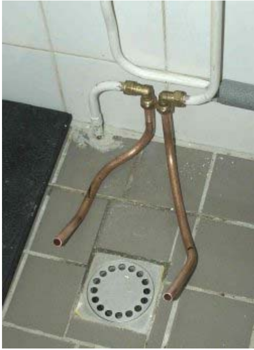
Fig. 2. Detail modificatie koudwater aan/afvoer (van boven).
