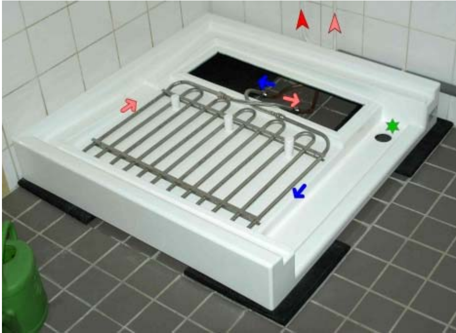
Fig. 3. Aansluiting Pristine douchebak (bodemplaat tijdelijk verwijderd).
